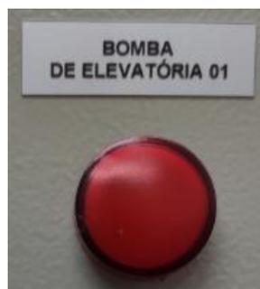
Bomba 01 da elevatória: desligada
