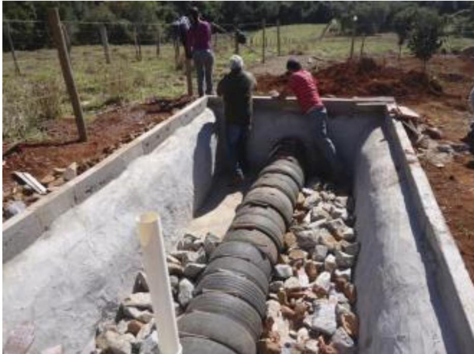
A camada de entulho deve ser suficiente para cobrir os pneus. Depois do entulho vem uma camada de brita 01 ou 02 (20-30cm), pedrisco fino ou areia grossa (10- 20 cm) e depois terra (20- 30cm).
