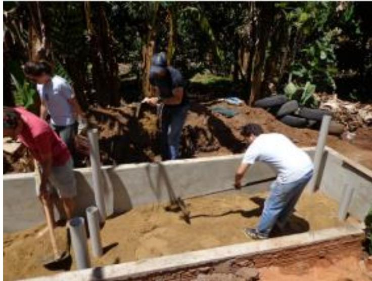
Sobre a camada de areia, deve ser colocada uma camada de terra e plantados as mudas de bananeira;
