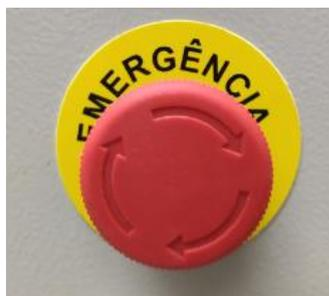
Pressionar em caso de emergência, para desligar as bombas, girar para retirar do modo de emergência.
