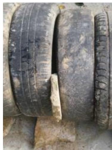
Depois de colocados os pneus, começa o preenchimento com entulho “limpo” (camada de 50-60 cm). Podem ser usadas telhas de barro antigas, cacos de bloco ou tijolo, pedaços de concreto. Não deve ser utilizado material muito fino e sujo (restos de argamassa e cimento, papelão, madeira, etc). Se não houver entulho disponível, pedras grandes poderão ser utilizadas.
