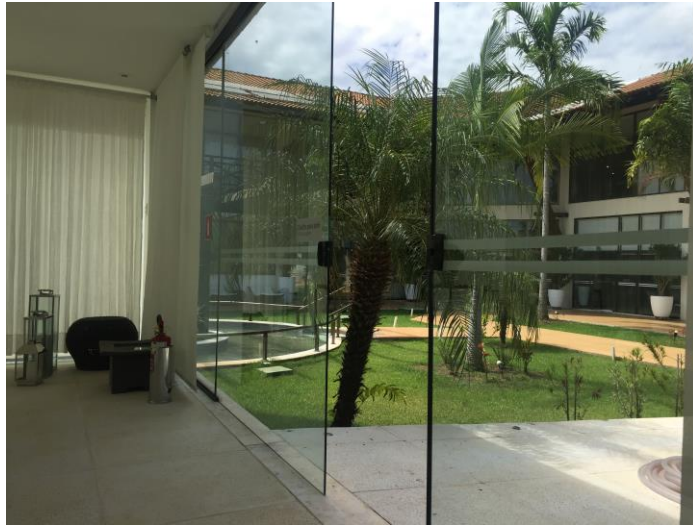
Figura 6 – Todos os vidros no entorno do quiosque serão removidos
