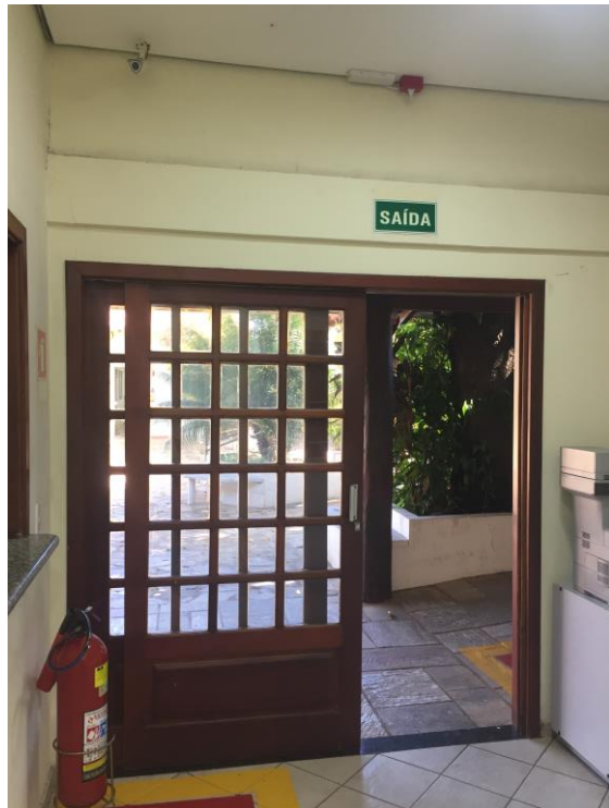
Figura 2 – Esquadria a ser removida, ponto de energia e câmara à serem reposicionados
