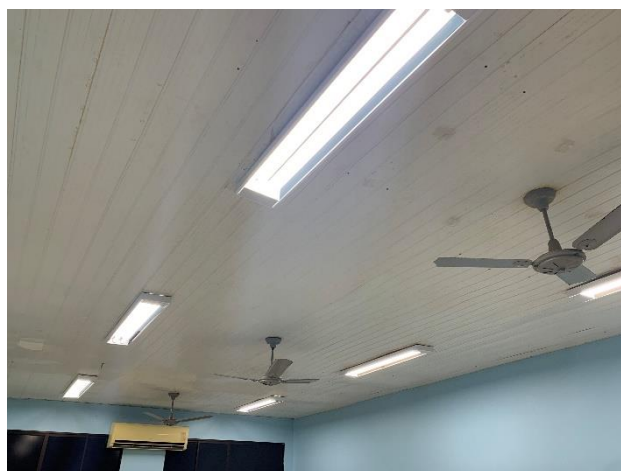
Figura 1 - Forro de PVC a ser removido e substituído por gesso, luminárias serão reutilizadas nos mesmos locais
