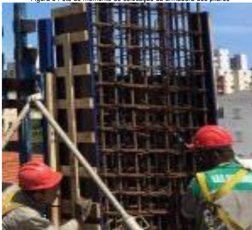
Figura 3 Foto do momento de colocação da armadura dos pilares
