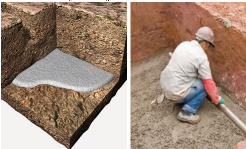
Figura 4 Concretagem do lastro - Fonte Universidade TRISUL
