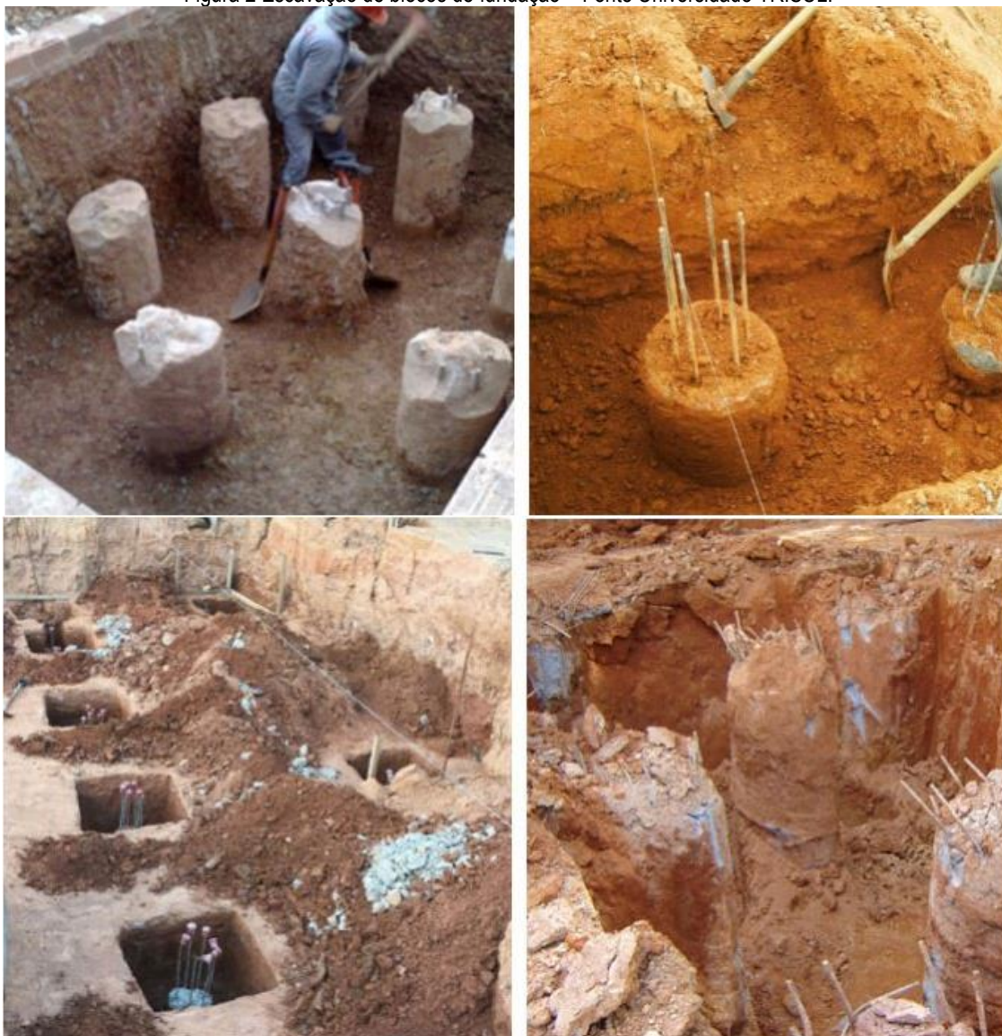
Figura 2 Escavação de blocos de fundação – Fonte Universidade TRISUL.
