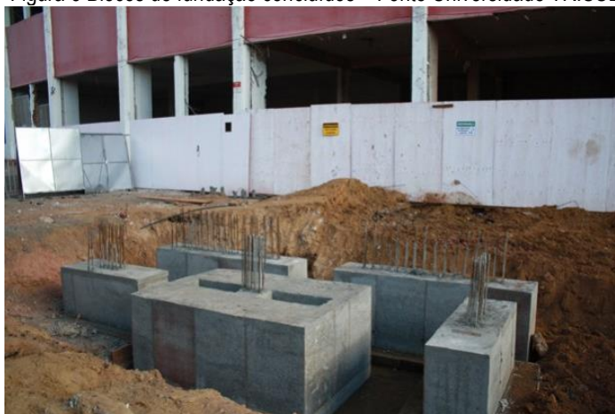
Figura 5 Blocos de fundação concluídos – Fonte Universidade TRISUL
